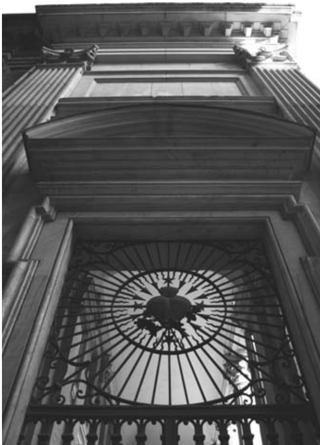
Figura 2. Chiesa di San Filippo, dettaglio del fronte laterale.
